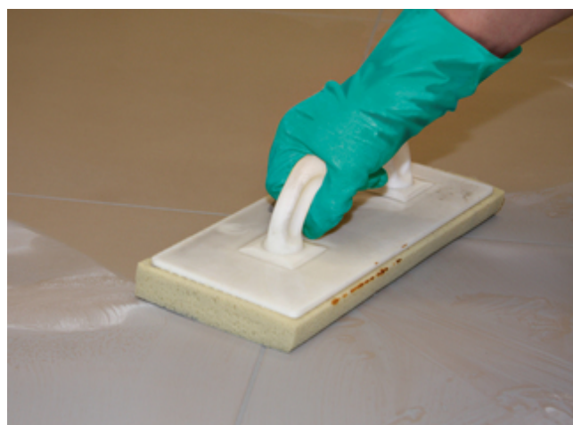
6 Abwaschen des Fliesenbelages nach ausreichender Standzeit der eingefugten Sopro Fugenmasse.
