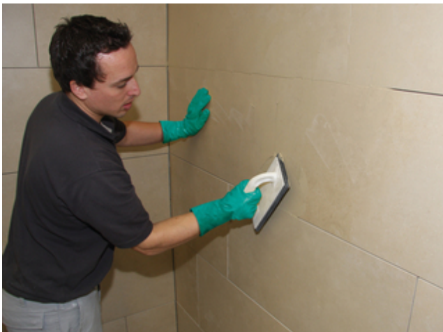
3 Verfugung der Fläche mit einer Sopro Fugenmasse (z.B. Sopro DF 10 DesignFuge Flex, Sopro Brillant Perlfuge)
