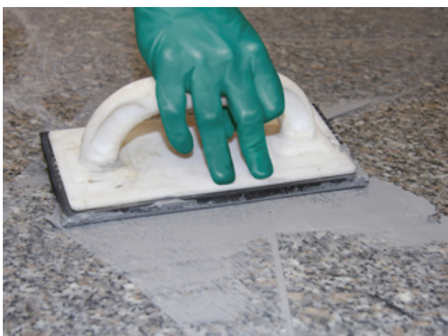
5 Verfugung des verlegten Natursteinbelages mit einer Sopro Fugenmasse (z.B. Sopro DF 10 DesignFuge Flex, Sopro Brillant Perlfuge).
