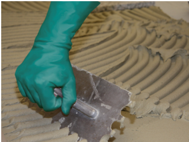
1 Aufziehen des Sopro FKM XL in Mittelbettkonsistenz mit einer Mittelbettkelle auf die vorbereitete Kontaktschicht.
