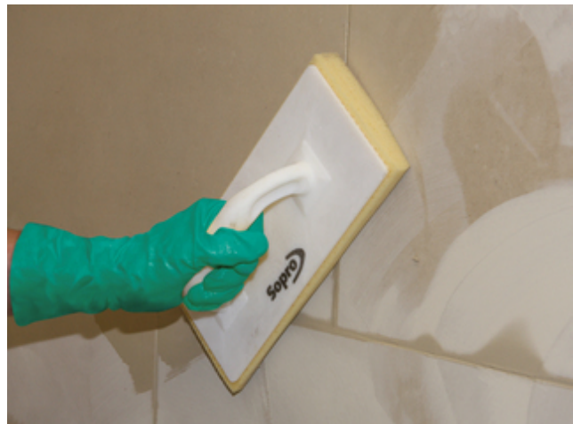
4 Abwaschen des Fliesenbelages nach ausreichender Standzeit der eingefügten Sopro Fugenmasse.
