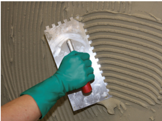
1 Aufziehen des Kammbettes in Wandkonsistenz auf die vorbereitete Kontaktschicht.
