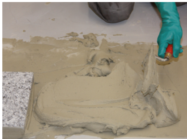
4 Sopro FKM XL ist für höhere Mörtelschichtstärken bis 10 mm auch mit der Kelle verarbeitbar.
