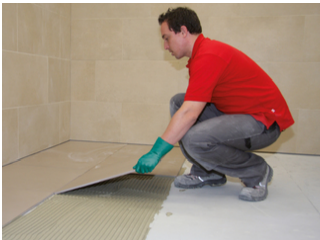
3 Großformatiges Feinsteinzeug einlegen und ausrichten. Fugennetz
