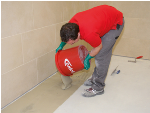
1 Ausgießen des FKM XL in Fließbettkonsistenz auf den vorbereiteten Untergrund.
