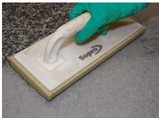
6 Abwaschen des Natursteinbelages nach ausreichender Standzeit der eingefugten Sopro Fugenmasse.
