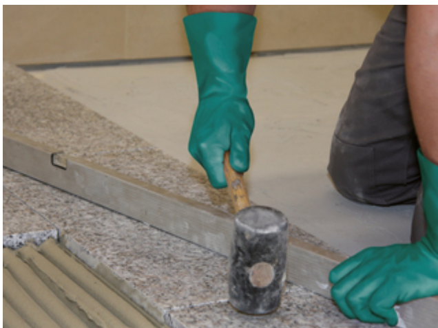
3 Einklopfen der Natursteinplatte und Überprüfung auf Ebenmäßigkeit.
